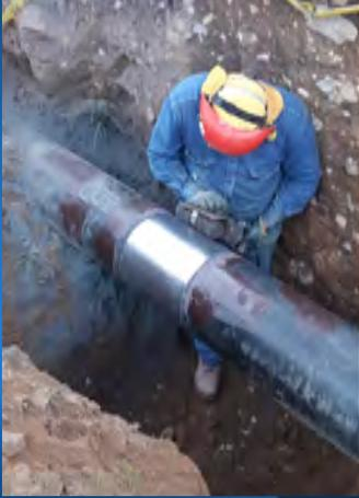
Revowrap es una solución compuesta de ingeniería que se utiliza para restablecer los activos críticos dañados a las especificaciones de diseño originales del equipo. Cada reparación se diseña utilizando los códigos de ingeniería ASME PCC2 o ISO TS 24817 para reparaciones no metálicas de alto riesgo.
